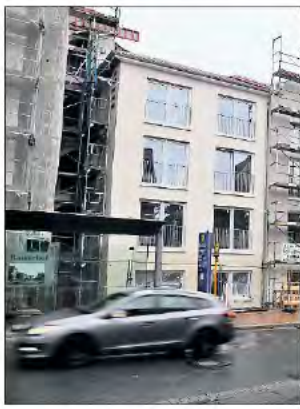
Am ersten Gebäudeteil des Seniorenpflegeheims am dem Gesundheitszentrum kommen planmäßig voran.
